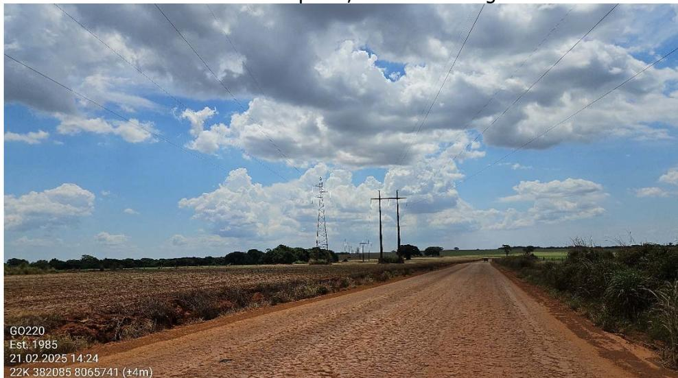
Foto 15 – Est. 1955+0 Curvas reversas em sequência. Possível alteração de traçado.
