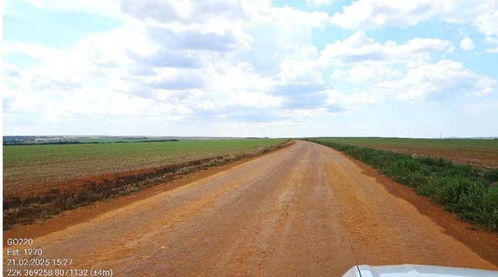
Foto 29 – Est. 1170+0 Terreno plano. Valetas de proteção da plataforma.
