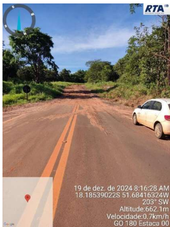
Foto 1 – Início do trecho de projeto (fim da pavimentação) – Coordenadas (18°11'7.40"S, 51°41'2.99"O)
