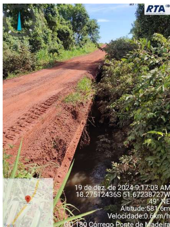
Foto 6 – Ponte de madeira no trecho – Coordenadas (18°16'30.12"S, 51°40'20.41"O)
