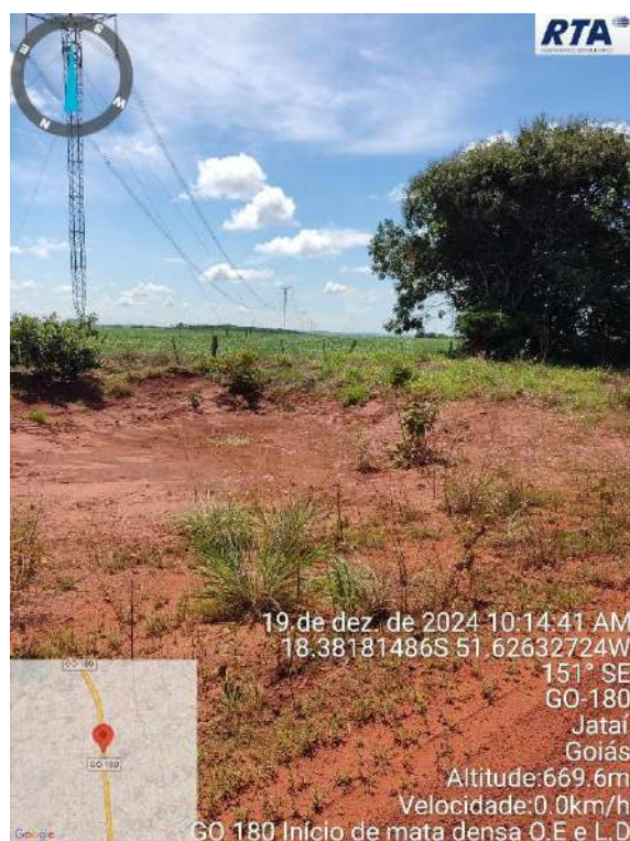
Foto 8 - Rede de alta tensão no trecho – Coordenadas (18°22'54.53"S, 51°37'34.79"O)
