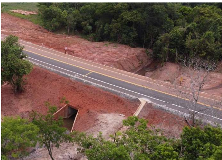
Figura 124 – Fotografia do bueiro existente
