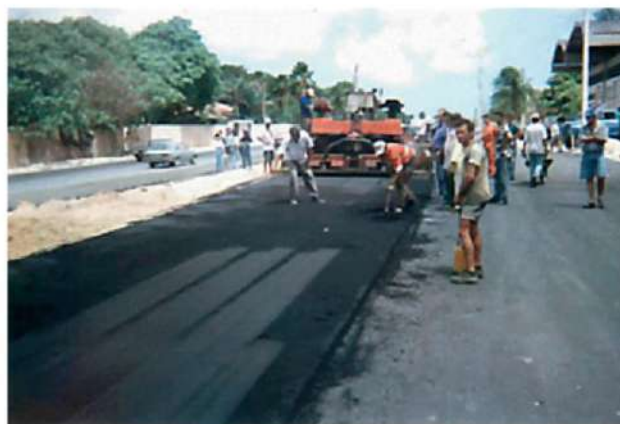
(b) Revestimento asfáltico sendo executado
